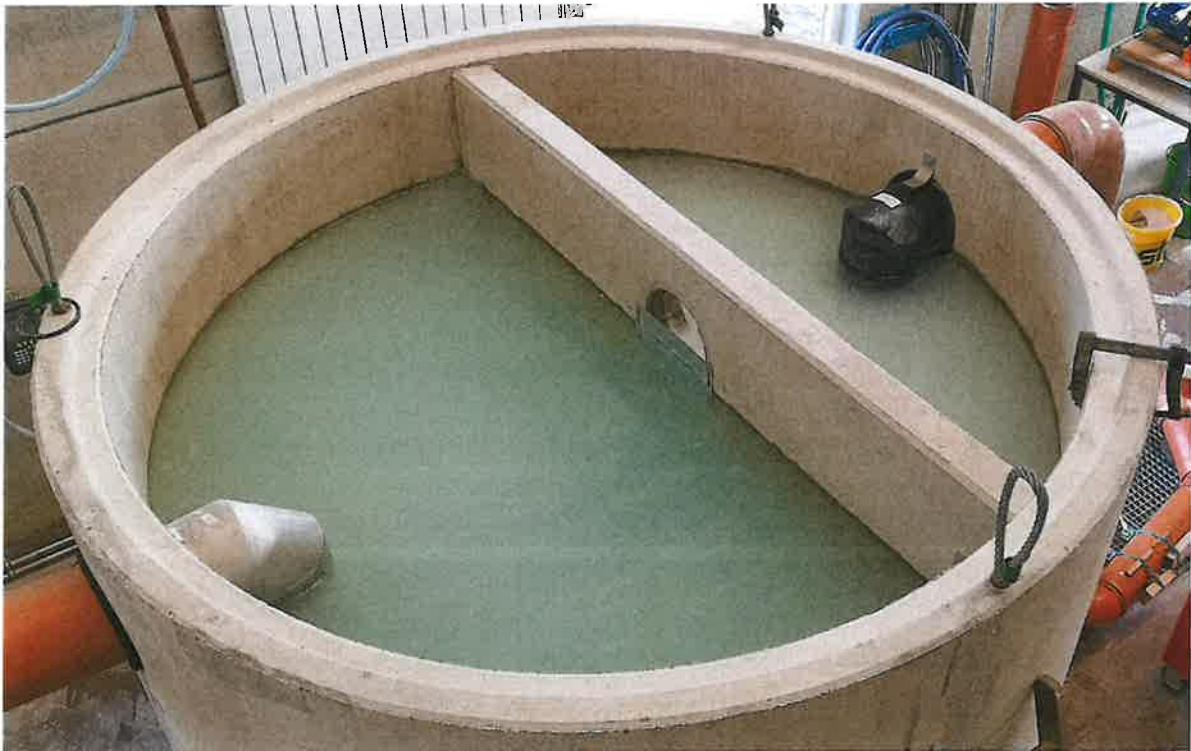
Abb. 2: Bypassöffnung in der Trennwand zwischen Zulauf- und Ablaufkammer der Behandlungsanlage.
