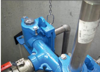
**Falls die erforderliche Überhöhung gegenüber der örtlichen Rückstauenebene nicht eingehalten und der Zufluss nicht sicher unterbrochen werden kann, ist eine Rückstausicherung hinter der Abscheideranlage mittels Doppelhebeanlage erforderlich.**
