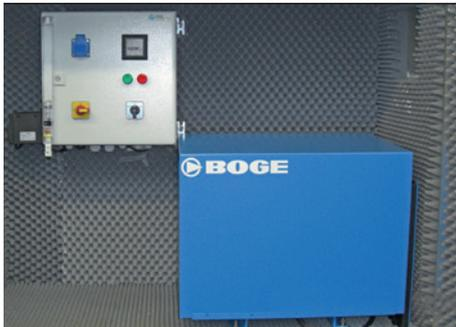
Mit Hilfe einer Kompressorstation wird die einer Pumpstation nachgelagerte Druckleitung mit Druckluft gespült, um die Verweilzeit des Abwassers im Kanal zu minimieren. So können Ablagerungen vermieden werden, die zwangsläufig anaerobe Fäulnisbildung nach sich ziehen.
