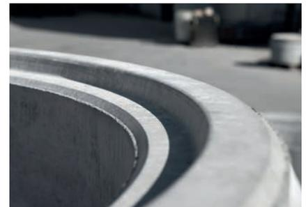
Bauteilverbinding mit Falz und bauseitiger Mörtelfuge.
