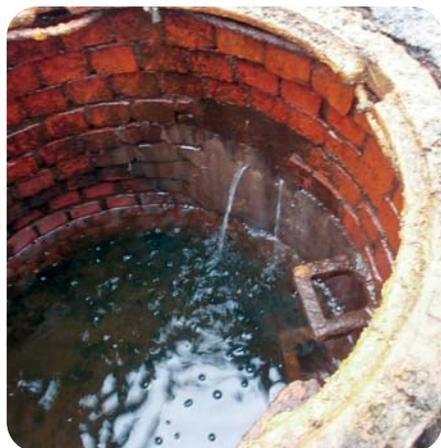
Defekter Schacht einer Abscheideranlage
