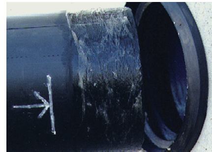
Bild 8: Herstellen der Rohranschlüsse
