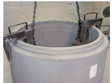
Bild 3: Schachtgehänge mit Klauen
