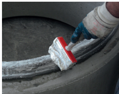
Bild 5: Auftragen des Gleitmittels
