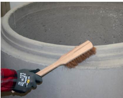
Bild 4: Reinigung der Verbindungsflächen
